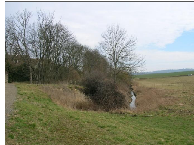
Le ru du travers à l'ouest du site
